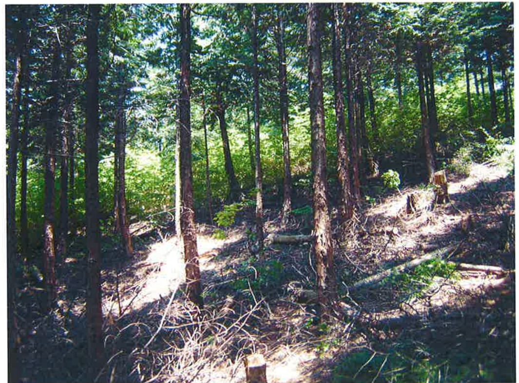
間伐作業完了後
