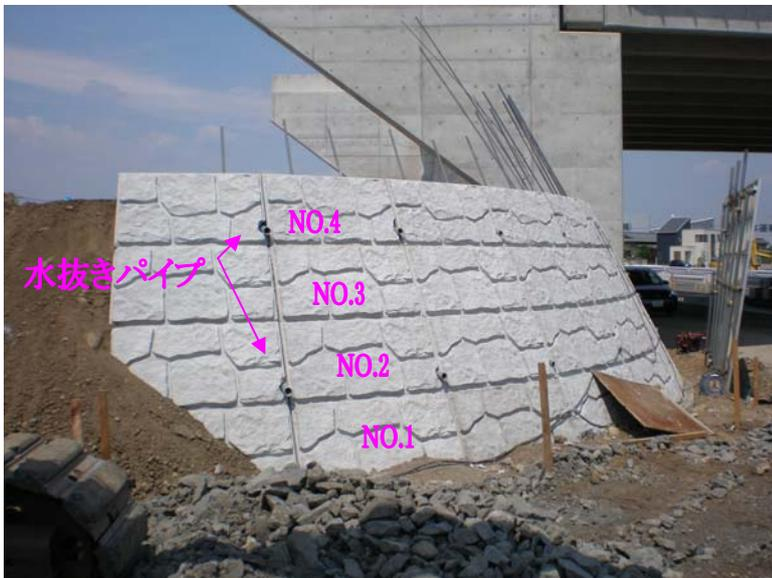
NO.2・4・6は水抜きパイプを設置する。
