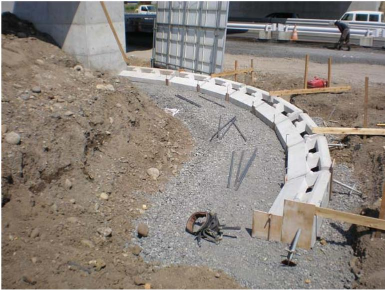
基礎碎石を施工後、所定の位置へ基礎ブロックを設置。縦断勾配は原則として水平とする。勾配がある場合は7%以下で一定勾配とする。
