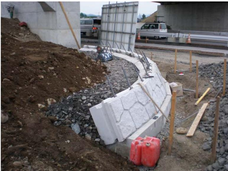
1段目ブロック (NO.1) を専用吊金具で設置。裏込碎石を施工する。
