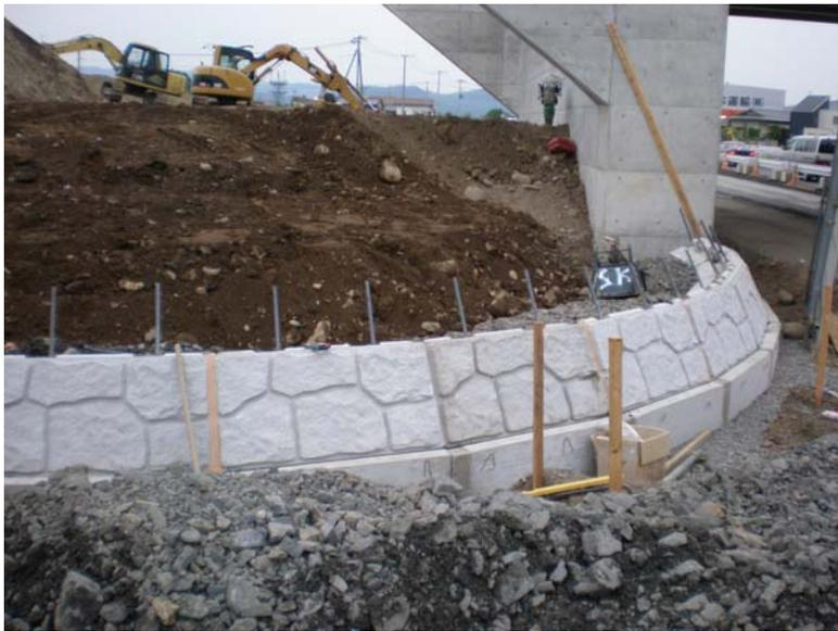
2 段目以降は工程により、ブロック設置→裏込工→横連結鉄筋設置の工程で数段積み上げて連結鉄筋を挿入し、間詰コンクリートを打設する。
