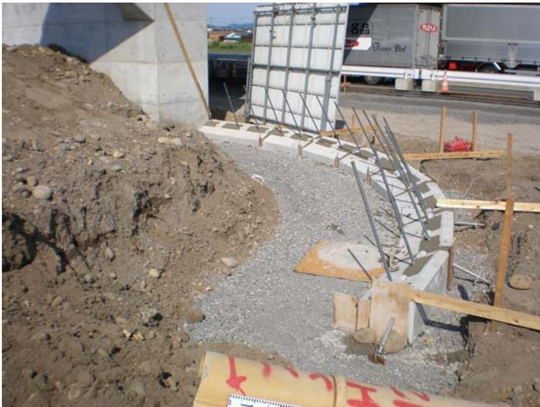
基礎ブロック設置後、胴込コンクリートを打設。位置を確認の上、連結鉄筋を基礎へ30cm挿入。
