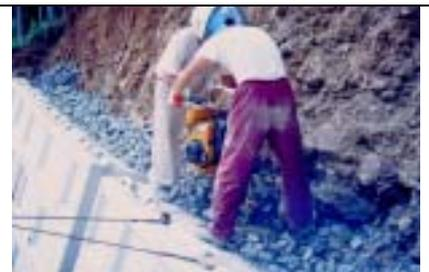
各段ごとに必ず裏グリを投入し、ブロックの微調整、裏グリの転圧を十分に行う。
