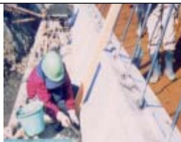
基礎挿入鉄筋や間詰めコンクリートにより 1 段目のブロックを基礎に定着させる。1 段目ブロック設置状態が施工性に大きく影響する。
