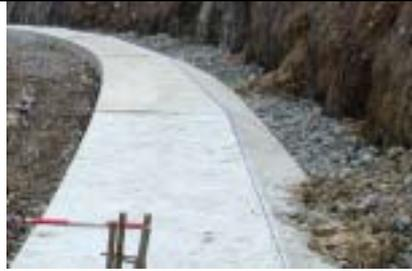
基礎は、縁切れ間のブロック設置面が直線になる様に施工する。
