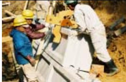
ブロックは所定の位置に正確に据え付けて、サポートを掛け安全に固定する。
