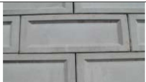
通常、ブロックの縦方向の隙間は、最小 2 mm、最大 10mm程度になるように施工する。
