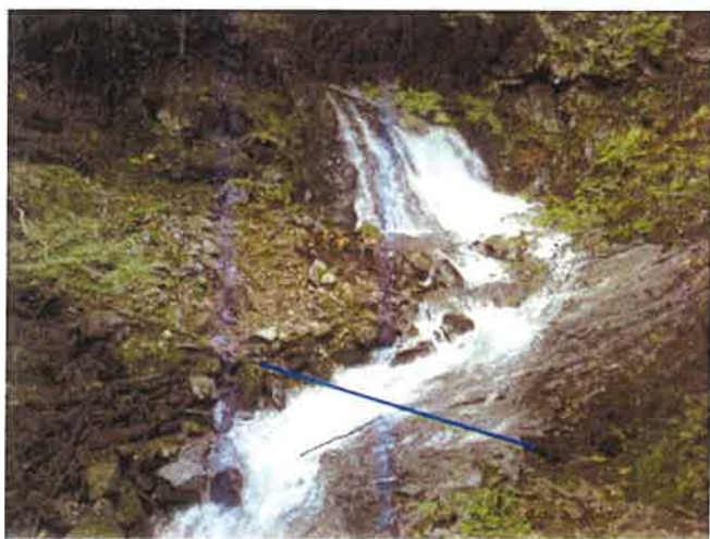
①丸太橋流失：起点250m～500mの間 ※ — 丸太橋が架けられていた場所
