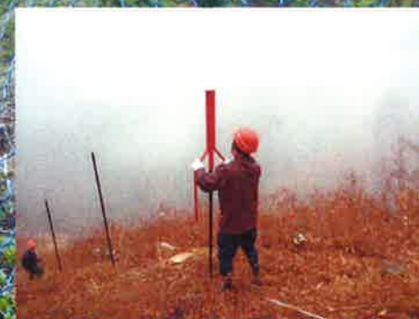
支柱打ち込み
